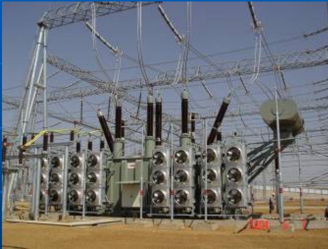
ABB autotransformer
