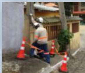
Instalación de medidores
